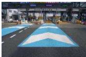
琵琶湖大橋料金所舗装修繕工事
